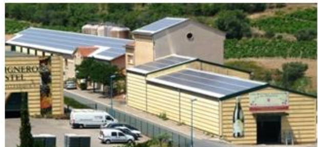
Cave Coopérative CASCATEL (11) Puissance électrique : 99 kWc Mise en service : Juillet 2010
