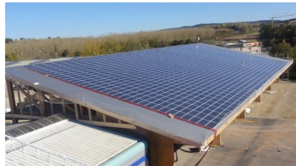
Bâtiment industriel RODEZ (12) Puissance électrique : 850 kWc Mise en service : Septembre 2011
